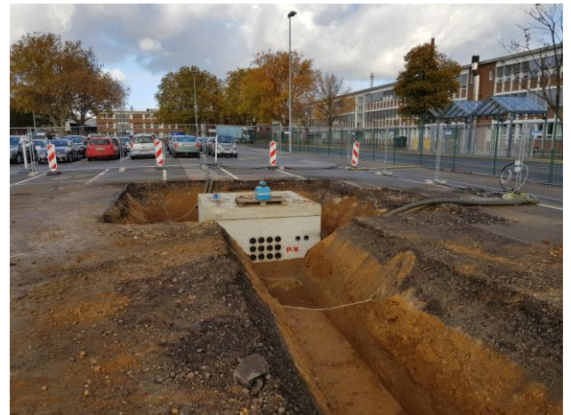
Foto zur Bauausführung
