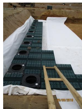
(Versickerungskörbe sowie Fahrzeugwaage)
