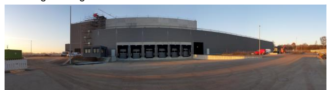
(Produktions- und Lagerhalle, Betonfläche)
