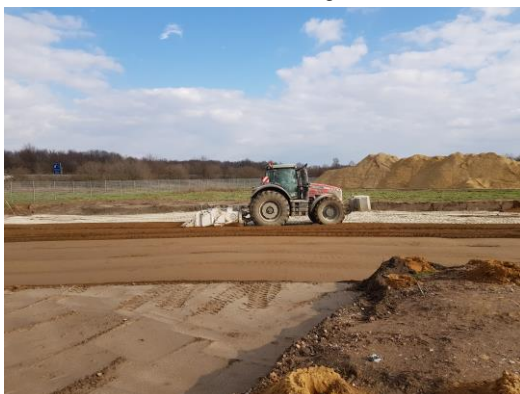
(Bodenaufbereitung / Bodenverbesserung)
