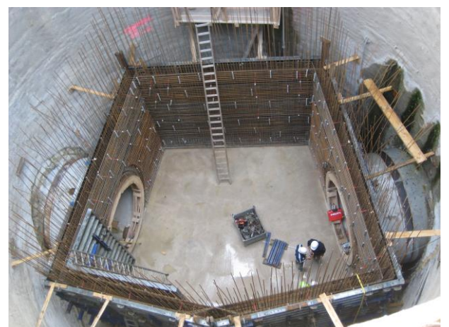
Beispiel: Herstellung Schachtbauwerk 6
