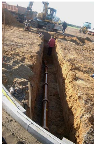
Verlegung der Entwässerungsleitungen
